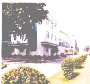
▲ 2002年9月，西安印钞厂建成的污水处理站
