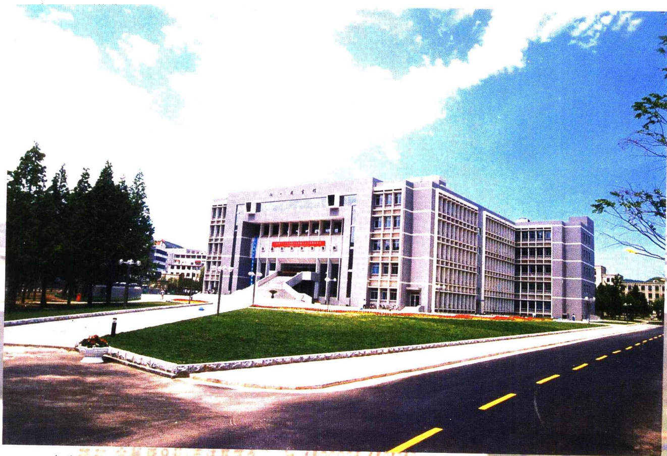
大连理工大学伯川图书馆荣获2000年度中国建筑工程鲁班奖（地上5层，地下1层，2.0万平方米）
