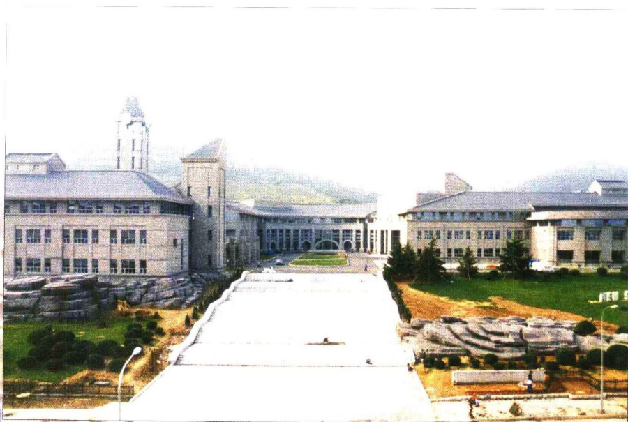
东信学院一期工程(荣获2002年度中国建筑工程鲁班奖)
