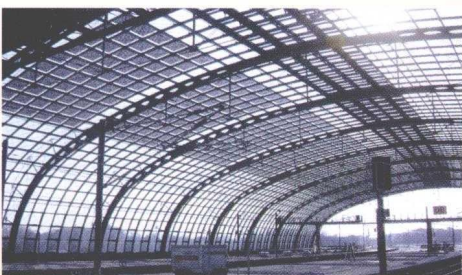
柏林火车站200kWp BIPV
