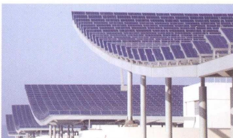
浙江义乌1.295Mwp并网光伏建筑一体化
