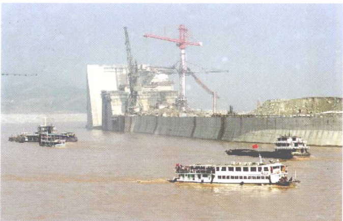
6日，人工开挖的3.5公里长、可供大型船队航行的三峡工程导流渠正式通航。
