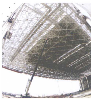
15日，上海浦东国际机场全面开工，建成后将与北京首都国际机场、香港国际机场成为中国三大国际航空港。
