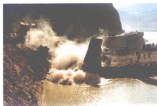
28日，中国治理黄河历史上最大的工程——黄河小浪底水利枢纽工程胜利截流。
