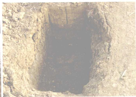
彩图3-2 挖掘机长方形树穴
