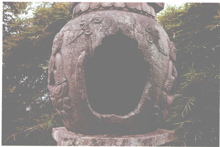
图二, 2 一号塔局部
