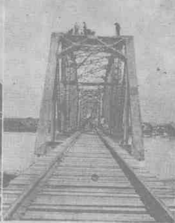
修復之涂家埠大橋（南潯段第一大橋）
