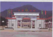
■ 新建的揭西县南山镇北溪小学大门
