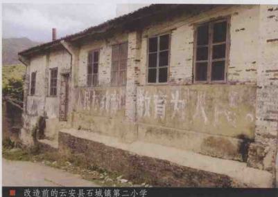
■ 改造前的云安县石城镇第二小学
