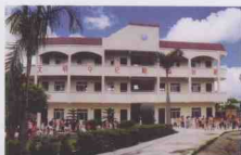
■ 廉江市石角镇塘墩小学新建成的教学楼
