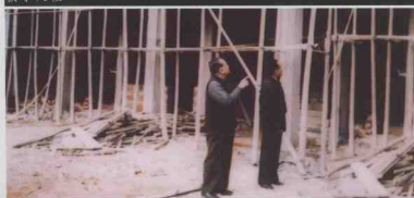
■ 省老促会常务副理事长曾洪在丰顺县老促会理事长陈修忠陪同下在黄金镇峰背小学建筑工地检查
