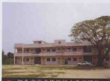
■ 阳春市岗美镇新圩小学新面貌
