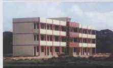
■ 电白县树仔镇乌石小学的新教学大楼
