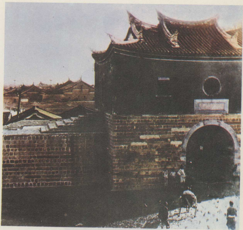
沈葆楨巡臺時，紳商集資興建的台北府承恩門(北門)舊觀。
