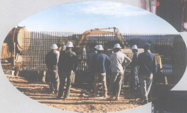
派往利比亚承建蓄水池的广东工人正在紧张施工（1985年）。
