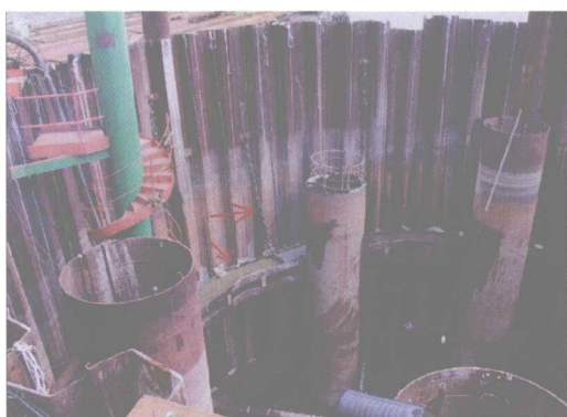
图 1.7-7(1) 围堰内支撑及吊点
