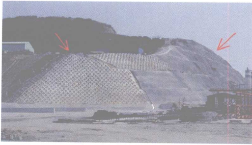
图 1.5—5 格栅、喷射混凝土护坡
