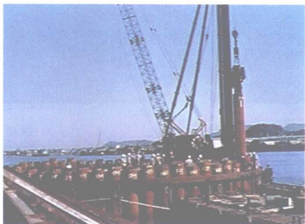
图 1.8—1 围堰插打
