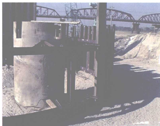
图 1.7-8(1) 围堰支撑及插打
