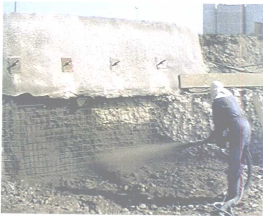
图 1.5—7 喷射速凝混凝土护坡
