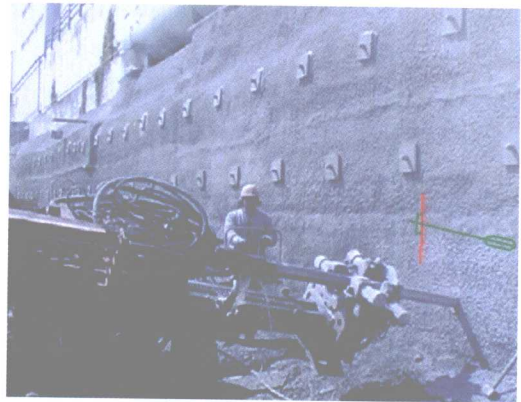
图 1.5—8 预应力锚筋护坡, 工序为 钻孔→植入锚筋→压浆→张拉
