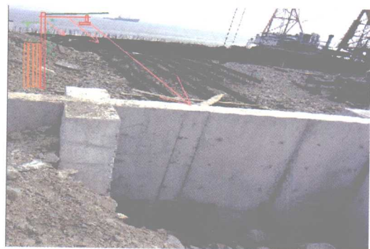
图 1.5—10 锚筋挡墙, 关注反力座至挡墙距离
