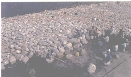
图 1.5—11 片石护坡，片石尺寸与水流速、坡度等参数相关
