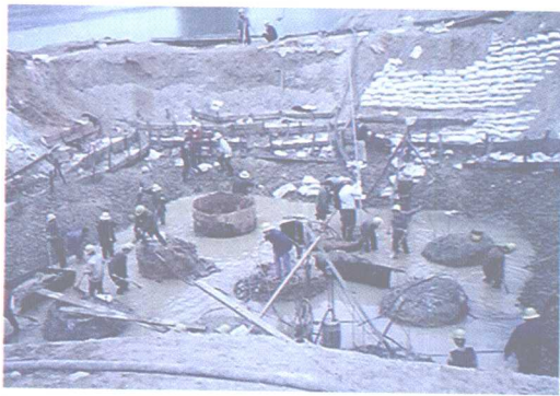
图 1.3—2 关注渗水量、排水能力及坑壁稳定性
