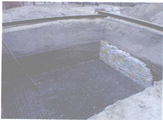
图 1.2 关注坑壁稳定性，宜尽量缩短施工周期
