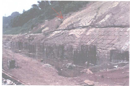
图 1.5—6 锚筋护坡, 工序为 钻孔→注浆→植入钢筋
