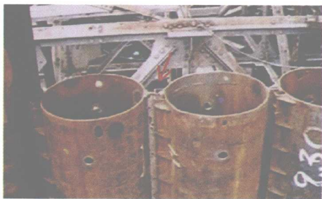
图 1.8—4 围堰锁口
