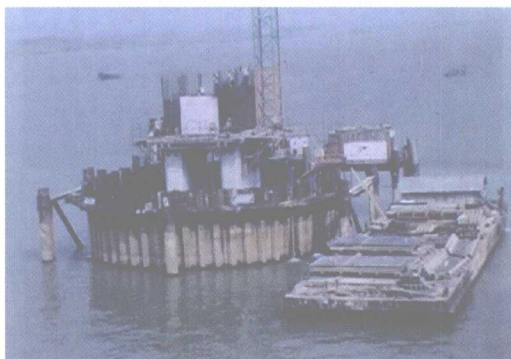
图 1.7-6 水中钢板桩围堰
