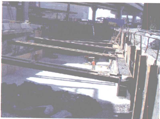
图 1.3—1 关注撑杆稳定及支撑桩入土深度
