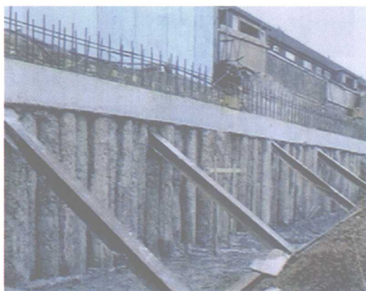
图 1.6—3 混凝土桩围堰加固支撑
