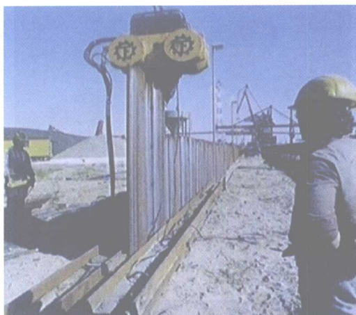
图 1.7-4 围堰插打
