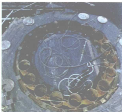
图 1.8—2 围堰及施工平台
