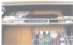
在出入口的部分预留墙壁厚度的空间,装设横杆置物架。平时使用卷帘加以掩饰。
