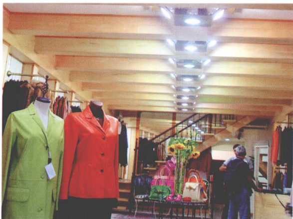
图1-1 采用木饰面材料作为造型的顶棚
