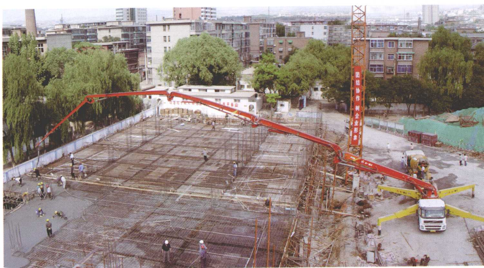
智海企业集团混凝土浇筑施工现场
