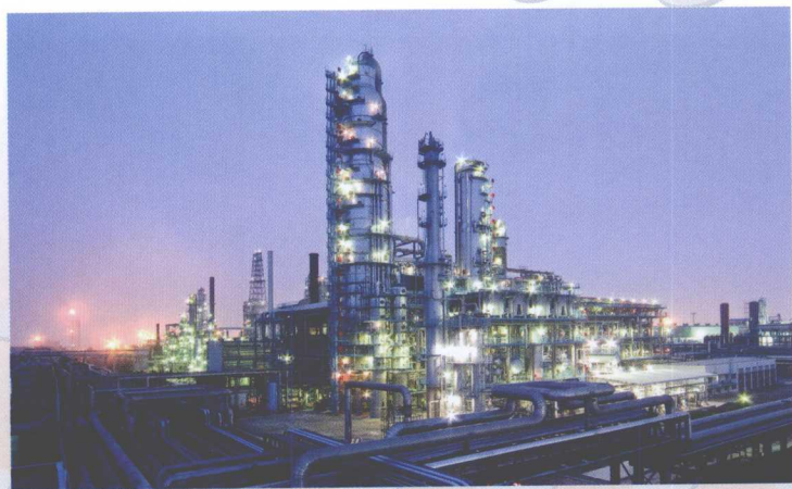
■ 高桥石化原油适应性改造项目——800万吨/年常减压蒸馏装置
