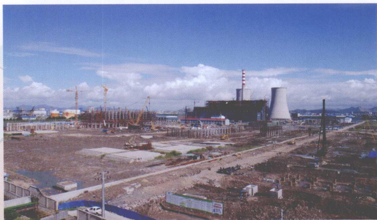
■ 镇海炼化乙烯工程建设现场
