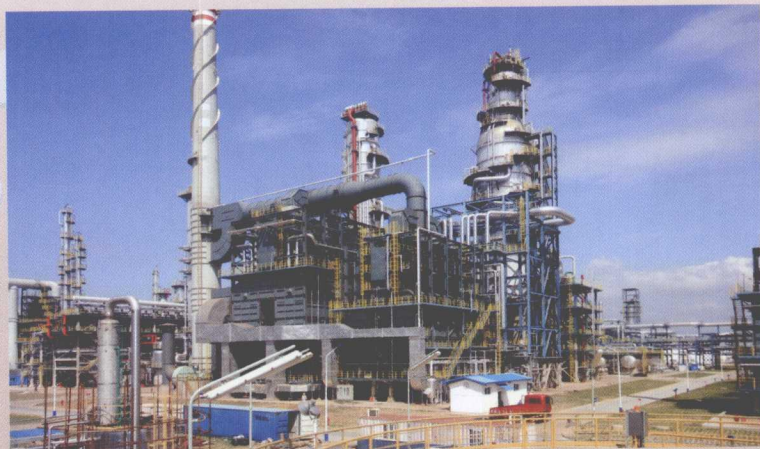
■ 福建炼化常减压装置
