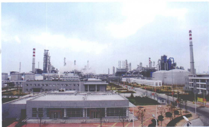
■ 青岛大炼油工程全貌
