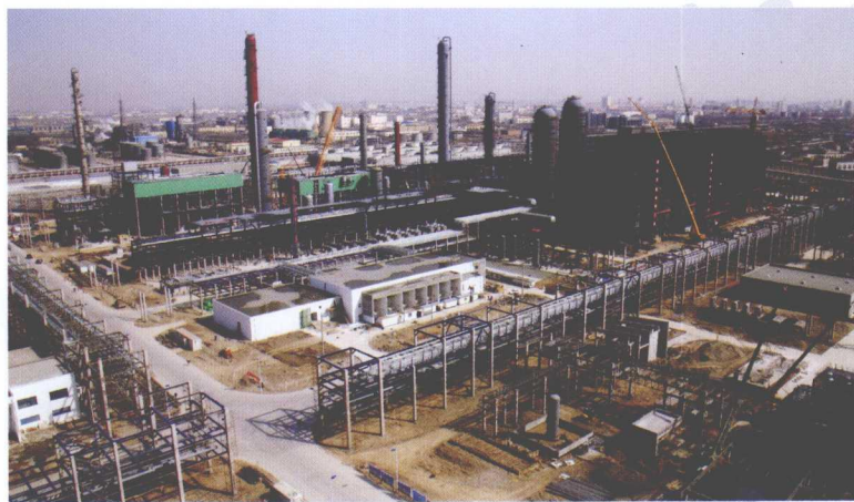
■ 天津石化乙烯工程施工现场
