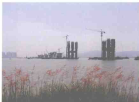
西湾大桥水上塔墩施工
