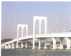
西湾大桥主塔
