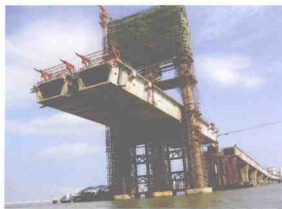
西湾大桥斜拉桥双箱主梁对称悬臂拼装施工
