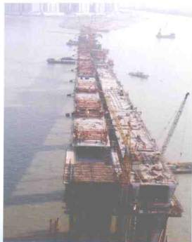
西湾大桥水上桥梁施工
