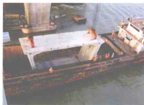
西湾大桥预制箱梁浮运起吊施工
