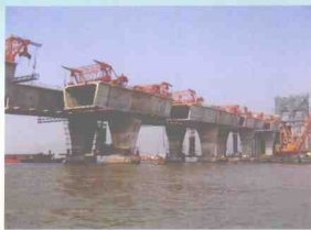
西湾大桥引桥主梁悬臂拼装施工
