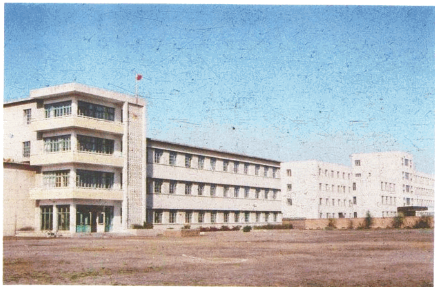
◀新建 67 中学教学楼(上)
