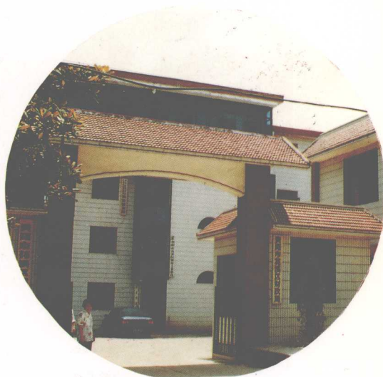
△ 花溪区财政局办公楼
