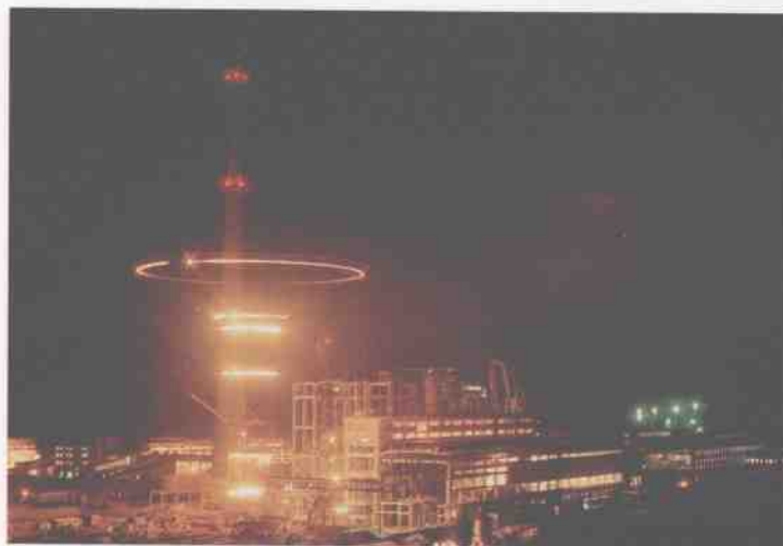
15 1987年,清镇发电厂三期扩建( 2 \times 20 万千瓦)工地
