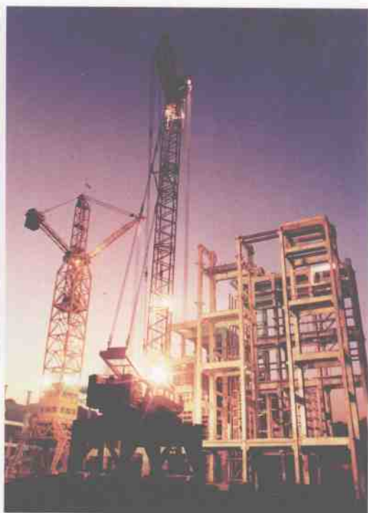
24 1990年，盘县电厂( 3 \times 20 万千瓦)建设工地
