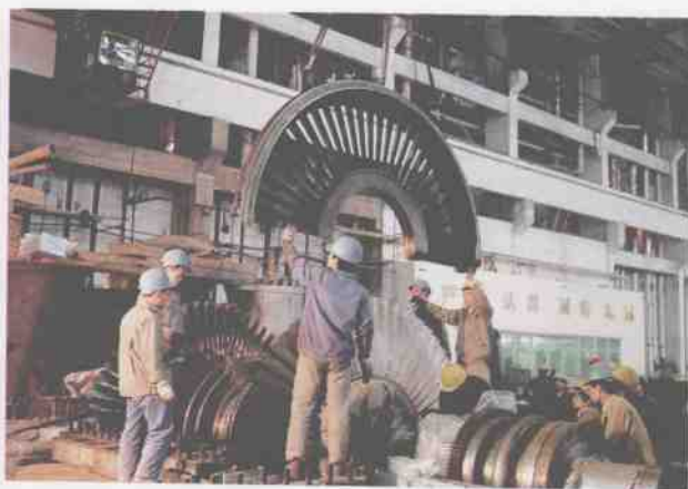
22 1990年，遵义发电厂扩建的第一台12.5万千瓦机组正在安装
