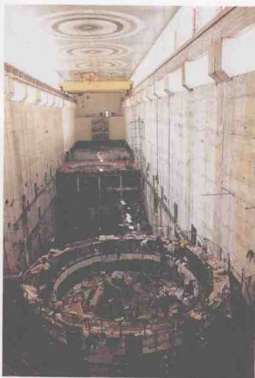
18 1990年,天生桥二级电站机组正在安装
