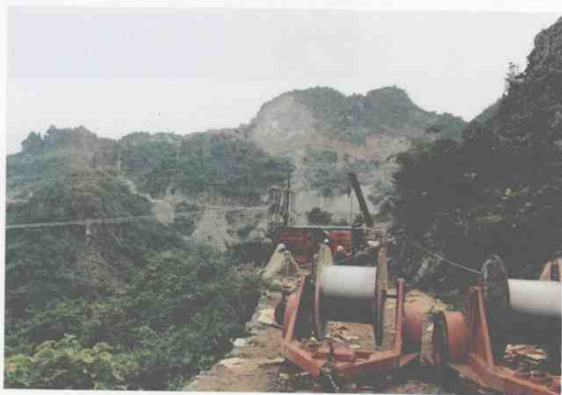
20 1990年，贵州第一条500千伏高压输电线路正在架设
