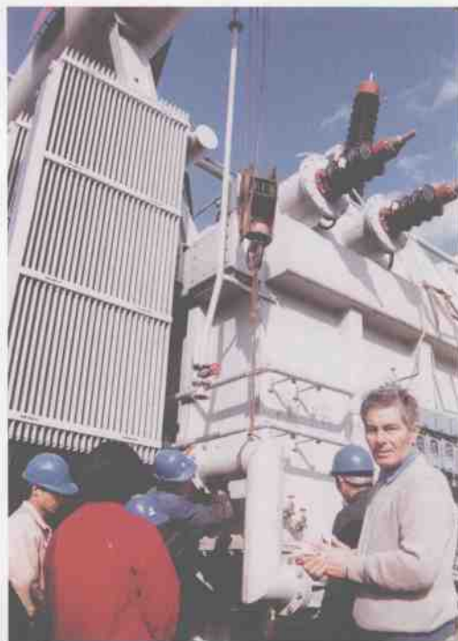
29 1990年，意大利专家在500千伏贵阳变电站 指导安装主变压器
