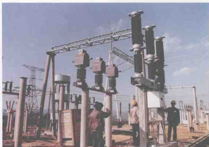
28 1990年，500千伏贵阳变电站在建设中
