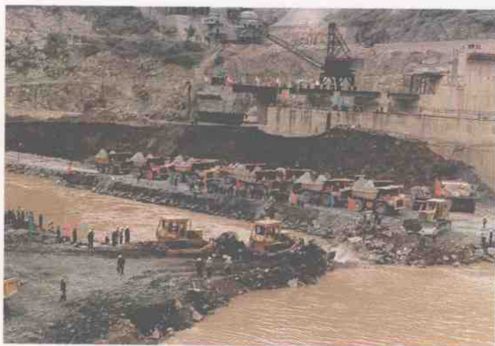
17 1986年11月19日,南盘江天生桥二级电站( 6 \times 22 万千瓦)一次截流成功
