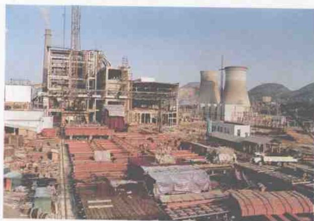
21 1990年，遵义发电厂扩建工地
