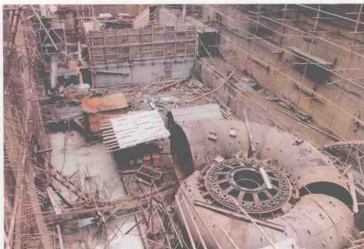
27 1990年，普定水电站建设工地
