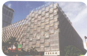
赛格科技园改造后实景
