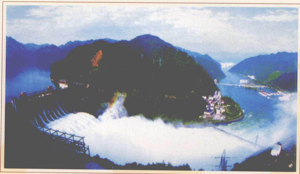
新安江水电站
