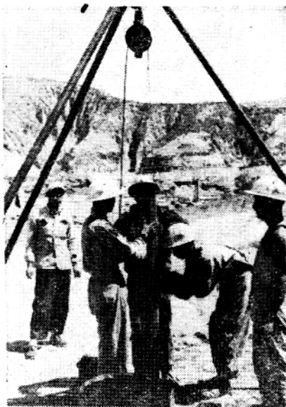
圖五：一九五三年三月份延長油鑛採納蘇聯專家的建議，實行了井底爆破作業，產量提高將近兩倍。這是該鑛員工正在向井下放置炸藥準備爆炸的情形。
