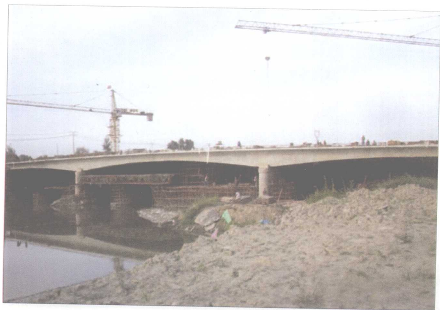
贤文路桥主体基本完成
