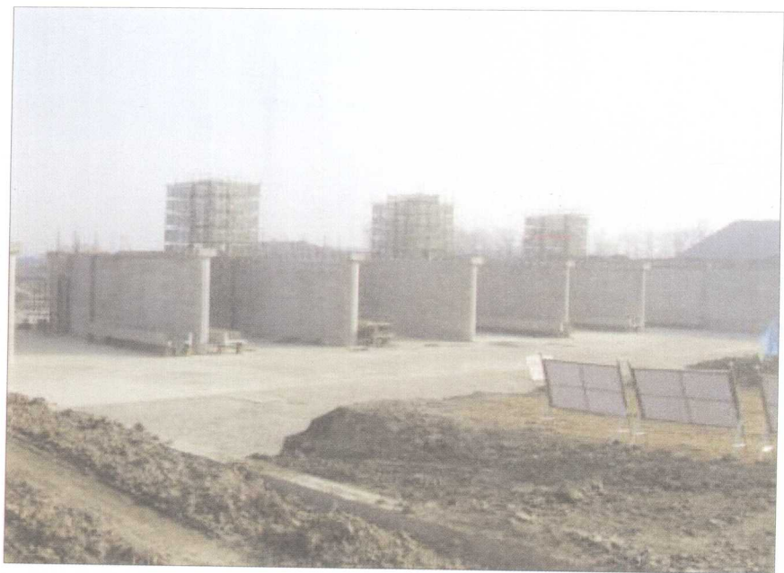
洪园节制闸主体工程基本完工
