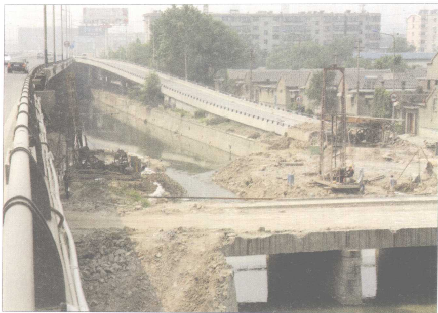
高架路桥下小清河施工现场
