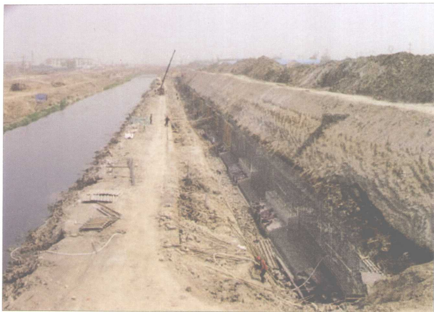
建设中的河道岸墙
