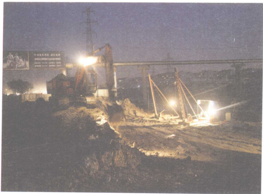
夜间施工现场
