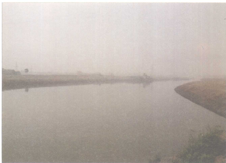
开挖后的土渠段
