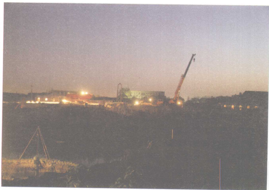
建设工地施工夜景
