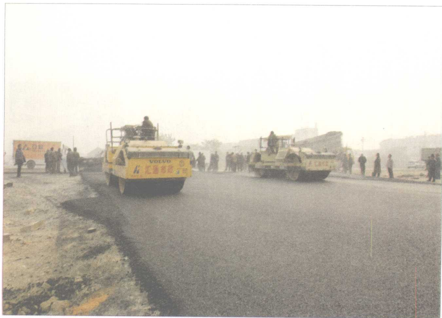
滨河南路沥青面层铺设
