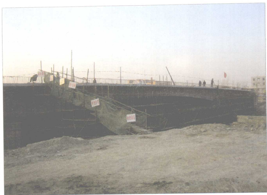
历黄路桥主体完工
