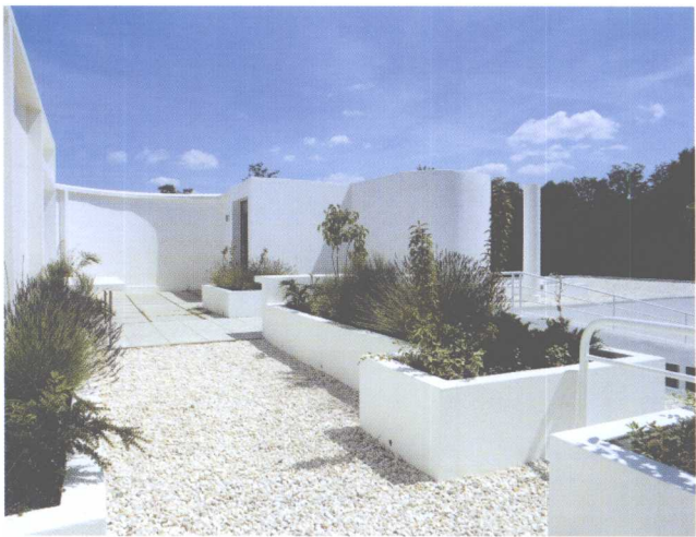
图 1-20 萨伏伊别墅的屋顶花园
