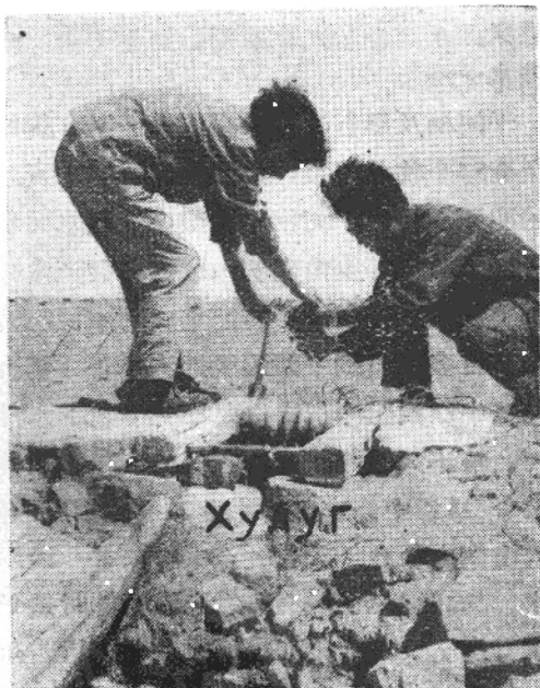
照片 4. 伊克昭盟牧區的牲畜飲水井（井口有木滑輪，井深一般大於 30 公尺，在砂岩中鑿成）
