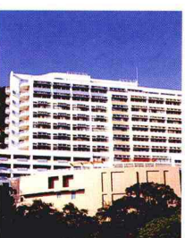
香港中文大学利黄瑶璧楼及 崇基学院行政楼 Esther Lee and Chung Chi College Administration Building, The Chinese University of Hong Kong 利安顾问有限公司 Leigh & Orange Ltd.
