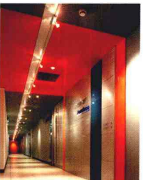
“数据堡”数据中心 「Powerbase」Data Centre
