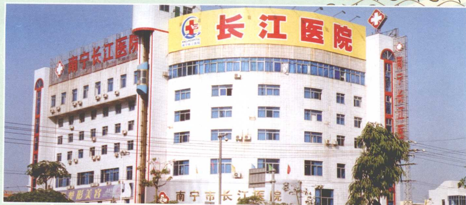
▲万秀村第一村民小组综合楼（长江医院）
