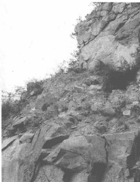
图 1.3 蛇盘岛某公路边坡上的结构面及由它们切割而成的多块体
