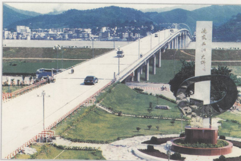
►新建的德庆西江大桥 (温爱民摄)
