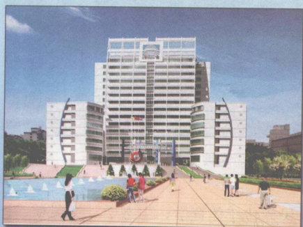
在建的教学大楼
