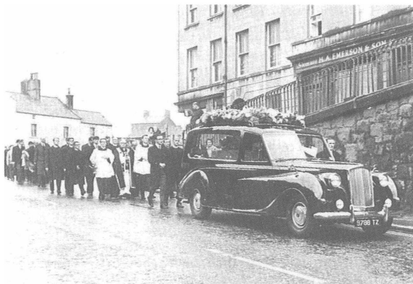
赫德出生地。现址为英国北爱尔兰亚马郡波泰荡镇渥特豪斯街42号,原屋已拆,现楼为一超级市场。此照摄于1968年9月8日,正值当地一丧礼队伍经过此楼。
