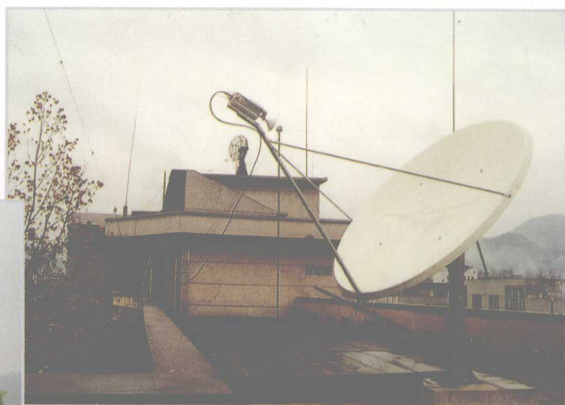
铜仁气象局 VSAT 天线
