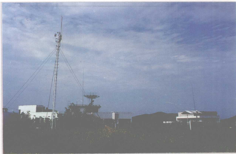
贵阳 701 探空站全景
