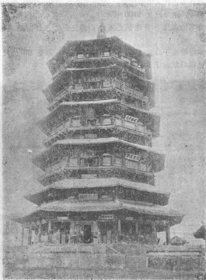
图 6 山西应县木塔，高 66m 建于公元 1056 年。
