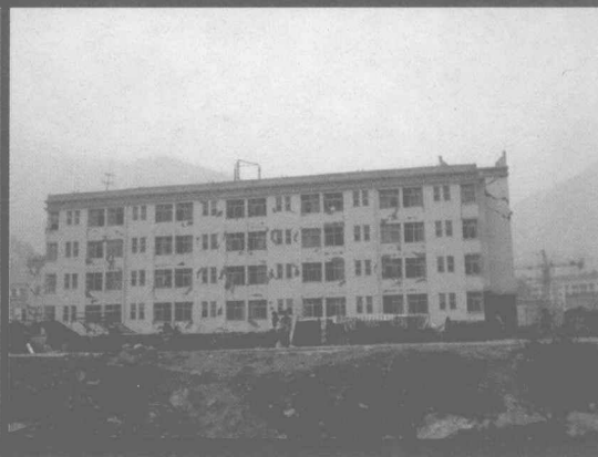
■远看大楼仍然完整，但实际一层已经全部坐塌
