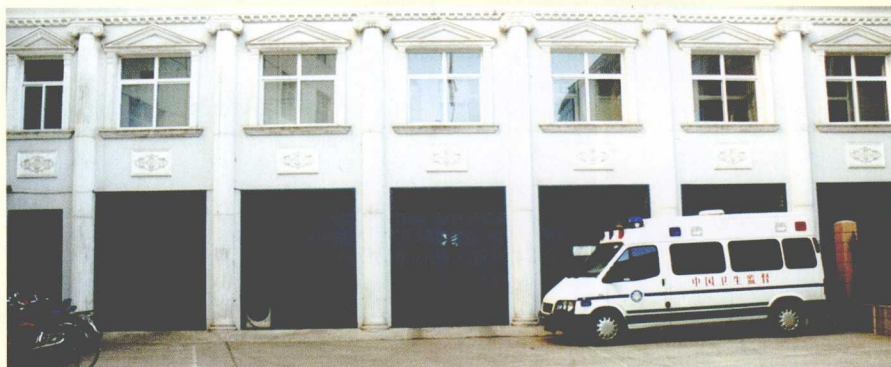
防疫站南办公楼
