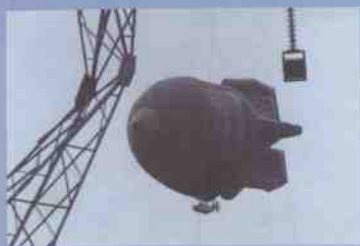
▲ 《蜜蜂6》热气飞艇成功地为葛洲坝高压输电线路架设电缆
