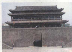
永宁门是西安城墙一城门，现在大家通常叫它南门。
