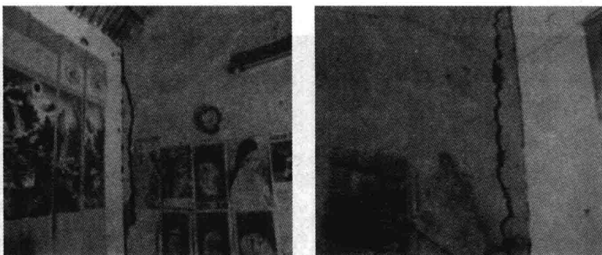
图 1-7 墙体受压开裂（裂缝宽度超过 2cm）
