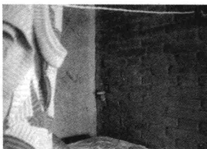
图 1-1 横墙受压裂缝
