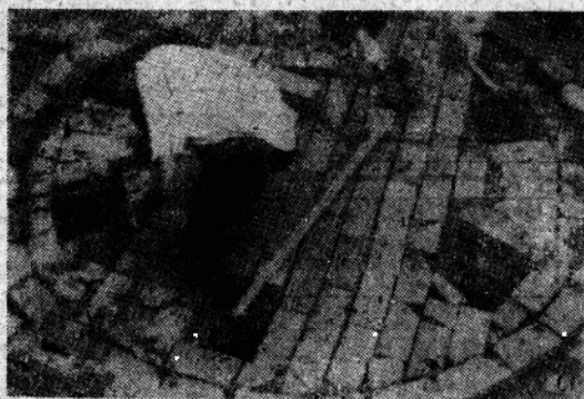
圖2 槽基的砌筑
