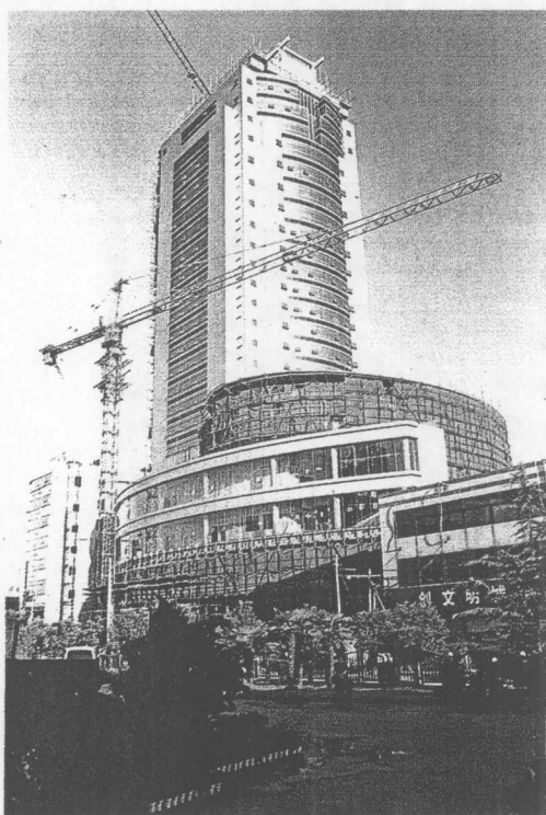
正在建设中的无锡广播电视大厦，1997年8月19日奠基，1999年12月底基本完工，建筑面积30000平方米。↑
