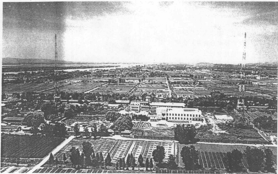
图中铁塔系国民党中央广播无线电台75千瓦发射机使用，高134米，1932年11月12日建成，德国西门子公司制造。此图为20世纪80年代中期拍摄。↑
