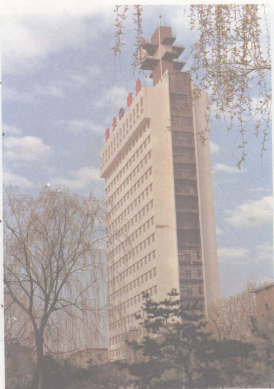
新落成的东北电网调度中心大楼
