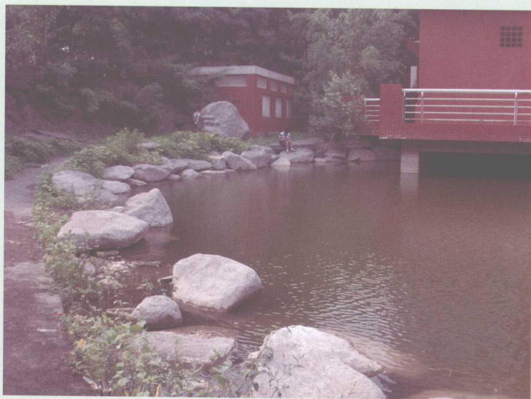
✦ 用本地石铺设的 滨河小路、修筑 的自然驳岸
