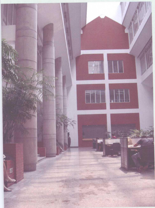
✚ 大厅的结构柱采用清水混凝土柱子装饰
