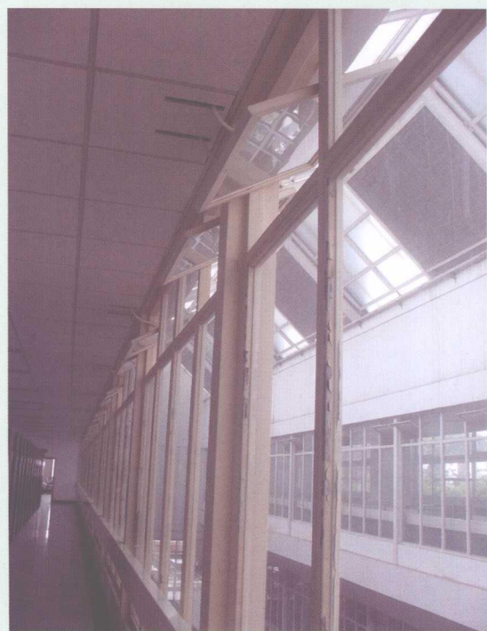
✦ 自制的中庭防火隔断中悬窗，简单、实用
