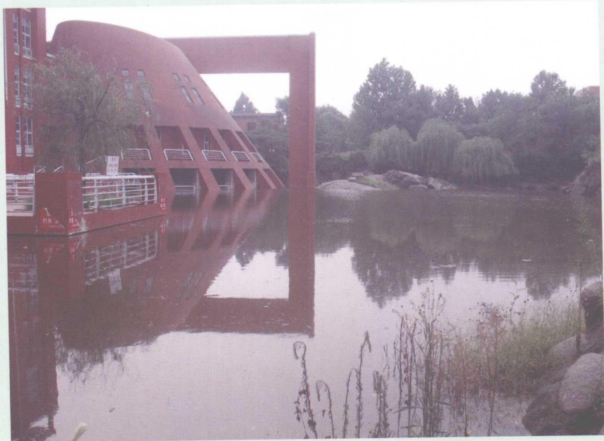
📌 景观水池池底铺设盘管代替空调冷却塔
