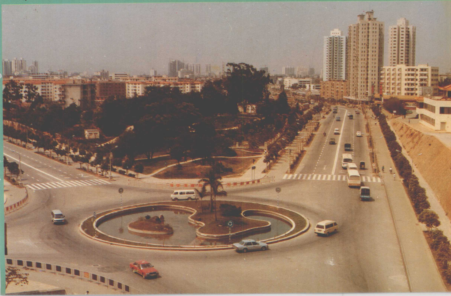
东门路、爱国路、怡景路交汇处
