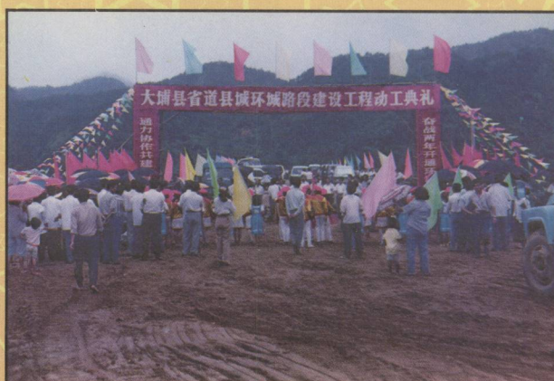
省道縣城環城路段建設工程動工興建
