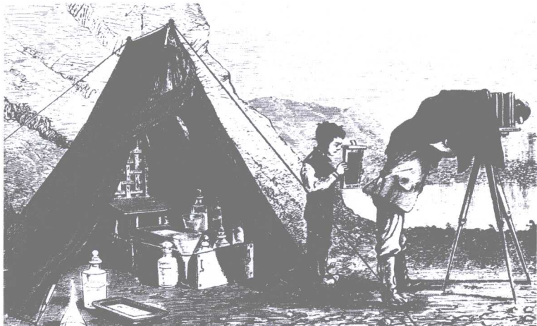
▲ 图1-6 “湿版”摄影法必须要使用暗房,为方便制作“火棉胶”底片,在室外拍摄时就要带上各种暗房设备和化学药品
