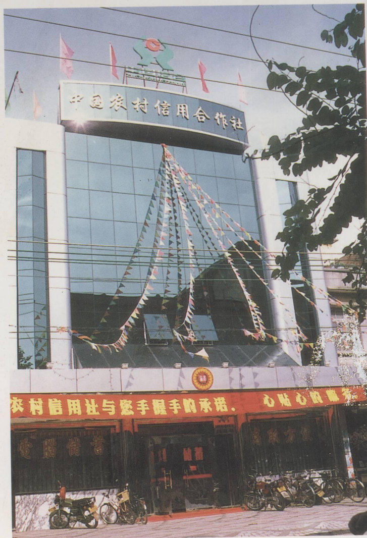
农村信用社大楼
