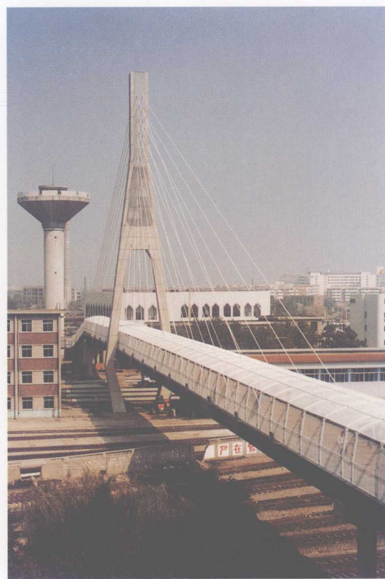
铁路天津站连接前后广场的人行天桥
