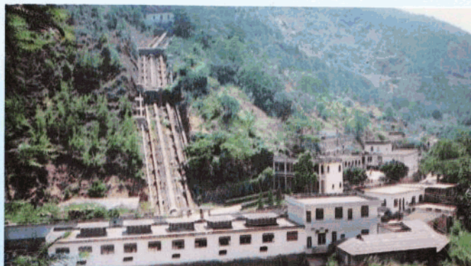
高陂 110 千伏输变电站全景
