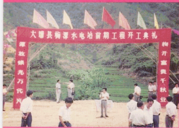
县梅潭水电站前期工程开工典礼（县水利局供稿）
