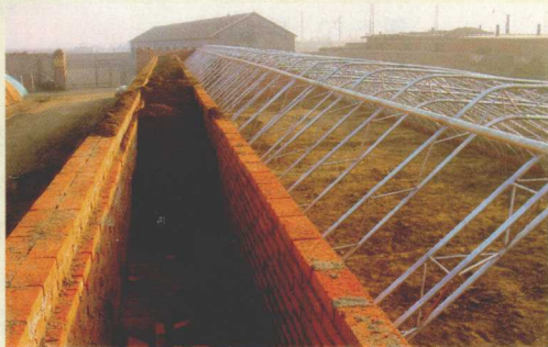
图 1-23 两层砖墙之间填 土可提高温室保温能力
