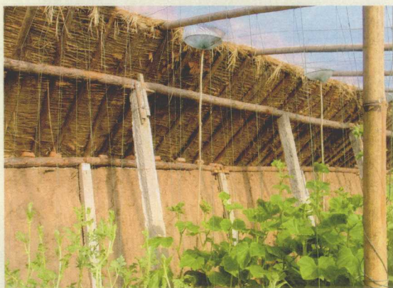
图1-14 温室后屋面椽子的下端要搭在檩上
