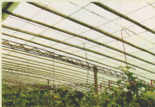
图 1-16 使用加强架和铅丝的琴弦式前屋面
