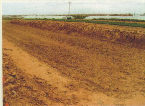
图1-11 挖土堆墙,建造半地下式温室
