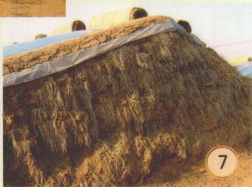
图1-12 土壤中掺入稻草,提高墙体的坚固性
