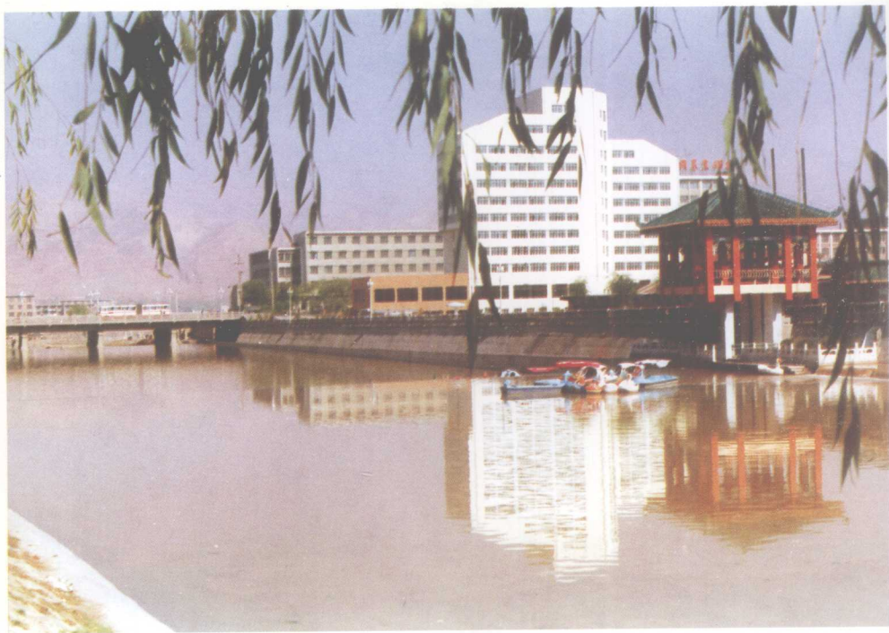
西宁市南川湟水河防汛大堤
